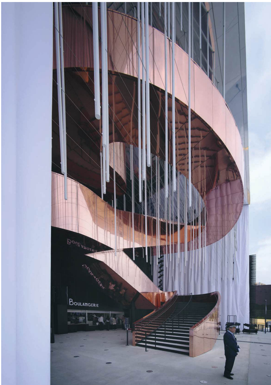
Haute de 17 mètres, la façade en rideau textile module la lumière du jour venant se refléter sur un monumental escalier de cuivre au gré du vent.
